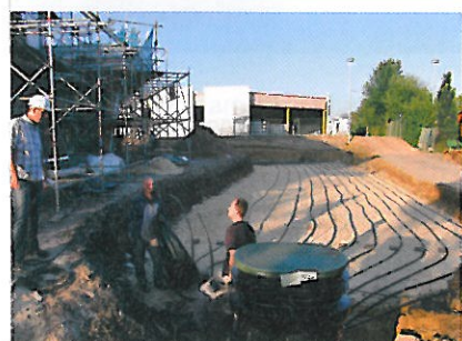
Horizontal verlegter Kollektor für Erdwärmepumpe
