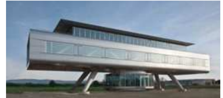
Bürogebäude Fuchs, Meißenheim
