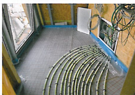
Heizkreisverteiler
