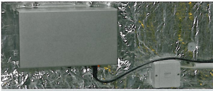
Der Ionisator für die Sauerstoffaktivierung ist in einem unscheinbaren grauen Kasten untergebracht. Er kann direkt an der Kanalwand installiert werden. (Abb. eht Siegmund)
