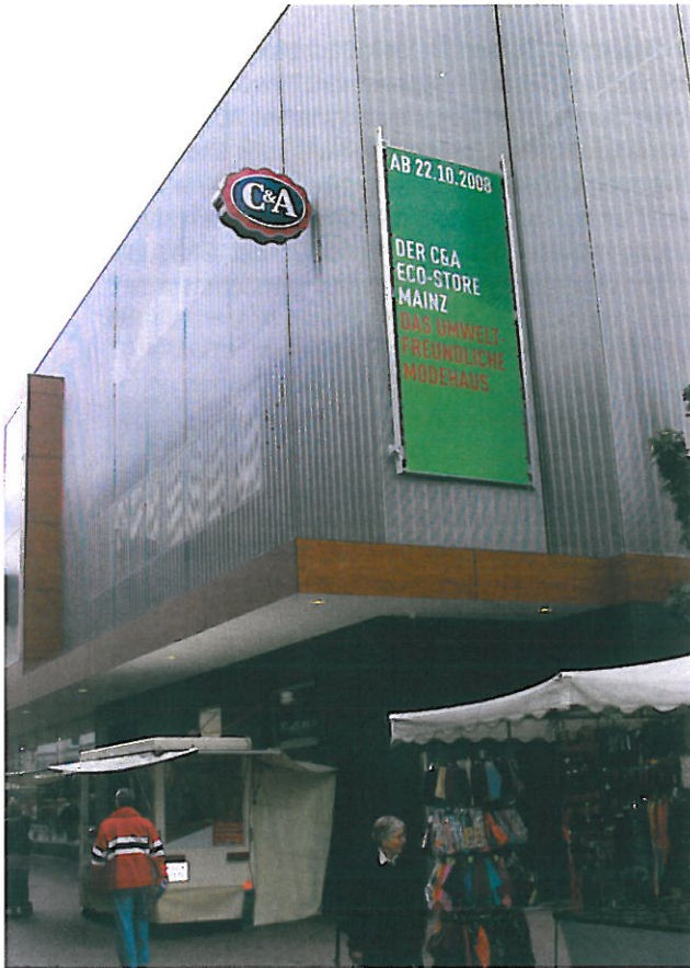
1 – C&A ECO-Store in Mainz mit zukunftsweisendem Energiekonzept
