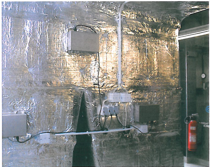
2 – Sauerstoffaktivierungssystem proOXION mit Ozongenerator und Ionenerzeuger
